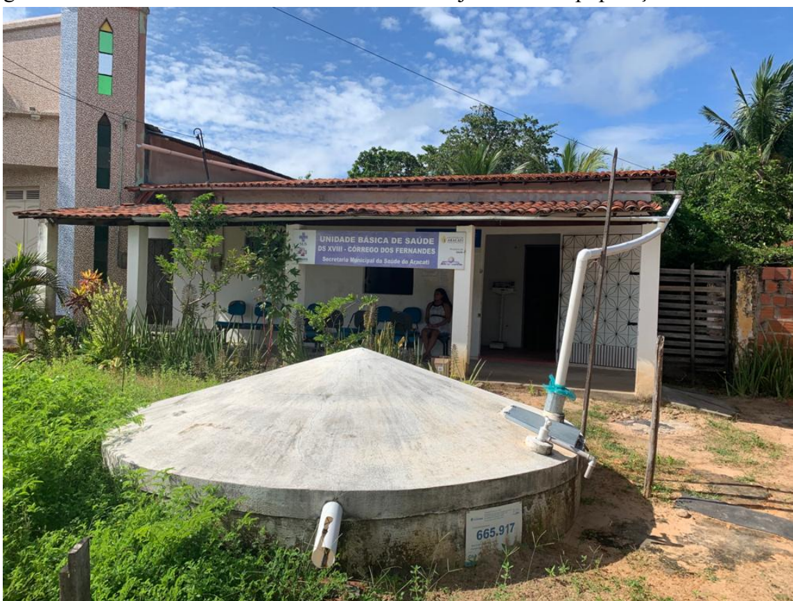
Figura 1. Unidade Básica de Saúde Córrego dos Fernandes.
